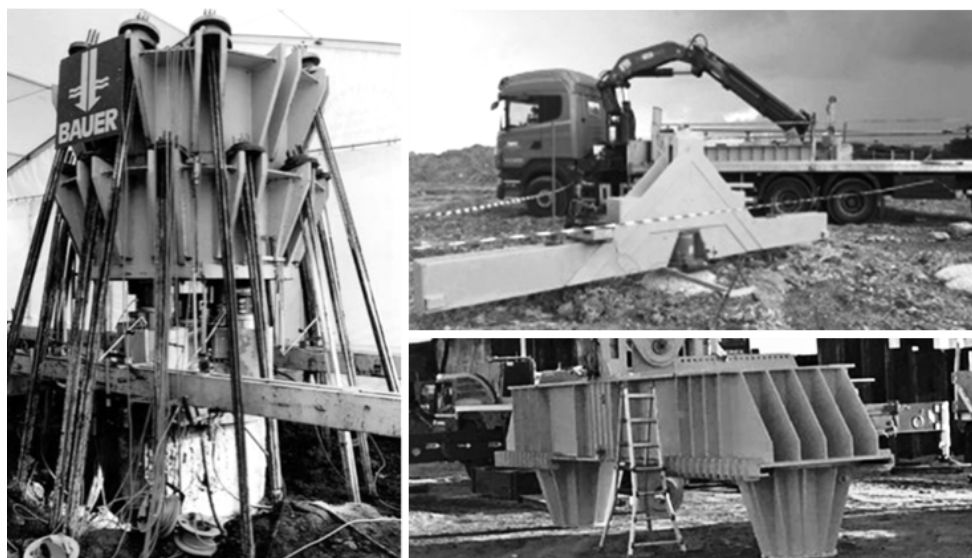
Рис. 2. Проведение статических испытаний грунтов с использованием натяжных элементов или специальных стальных конструкций
